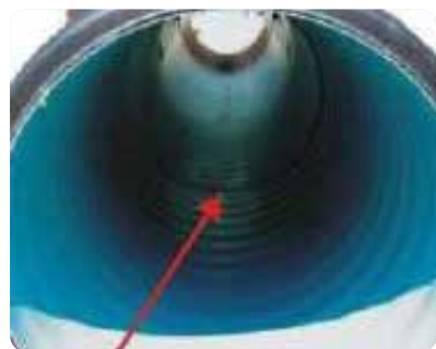
Abb. 3: Einschieben des Rohr-Spitzendes bis zum Anschlag der Rohrinne
