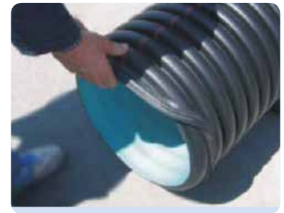
Abb. 1: nicht vormontierte Dichtringe auf das erste Wellental setzen
