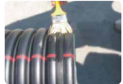
Abb. 2: Dichtring und Muffeninnenseite mit Gleitmittel bestreichen
