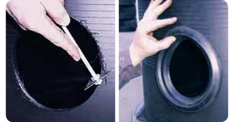
Rand entgraten, Bohrlochdichtung einsetzen
