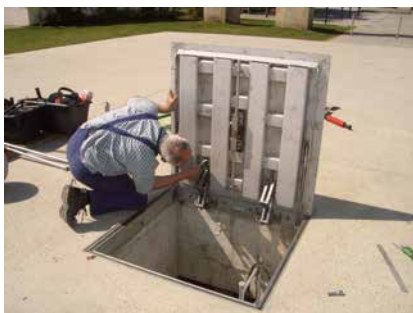
Nachträglicher Einbau einer Fluchtentriegelung vor Ort
