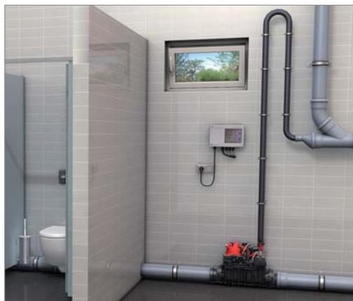
Für den privaten Einsatz. Abwasserentsorgung über natürliches Gefälle zum Kanal. Bei Rückstaugefahr Entwässerung mit Druckleitungsführung über die Rückstauene (Rückstauschleife) durch Abwasserhebeanlage.
