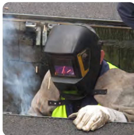
Sonderbau Mitarbeiter bei einer Deckelsanierung vor Ort
