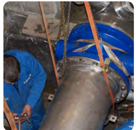
Montage einer großdimensionierten Pumpendruckleitung vor Ort
