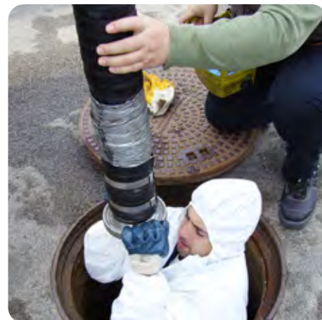
Schwierige Wartungsverhältnisse schrecken uns nicht ab!
