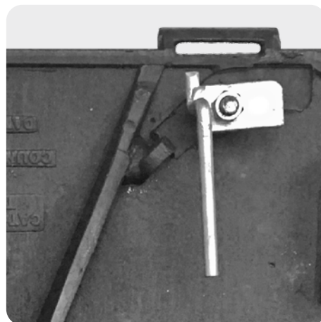
Spezialausführung Sonderbau: Flucht-Entriegelung für TETRA Schachtabdeckung
