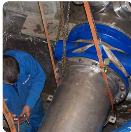
Montage einer großdimensionierten Pumpendruckleitung vor Ort
