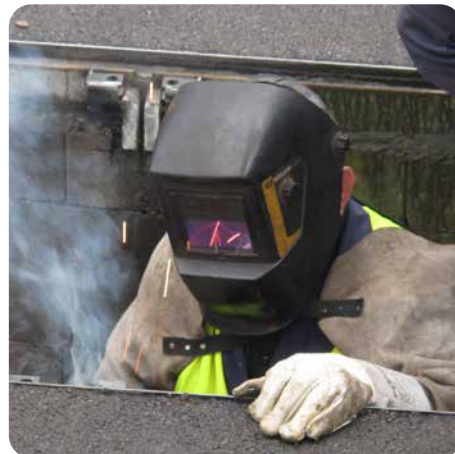
Sonderbau Mitarbeiter bei einer Deckelsanierung vor Ort
