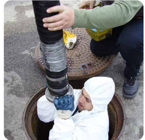
Schwierige Wartungsverhältnisse schrecken uns nicht ab!
