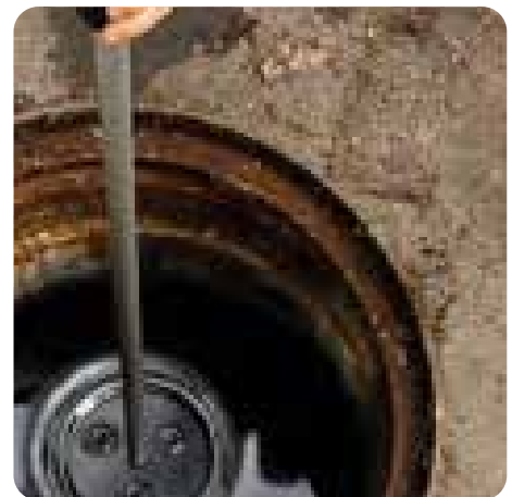
Sichtkontrolle der Abscheideroberfläche bei einem SeparatorsBLUE
