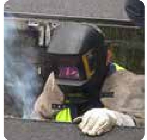
Sonderbau Mitarbeiter bei einer Deckelsanierung vor Ort
