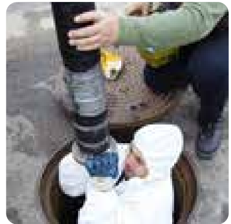
Schwierige Wartungsverhältnisse schrecken uns nicht ab!
