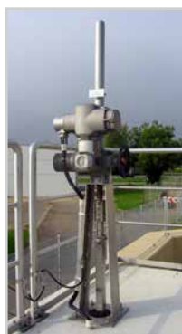
E-Antrieb mit Konsolenständer
