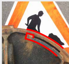
richtige horizontale Pos.: Federstab bogen etwa parallel zur Deckelrundung, Vorderkante des Federstabes ca. 8 mm über Rahmeninnenkante
