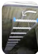
Sicherheitssteigleiter 400 mit Fallschutzschiene
