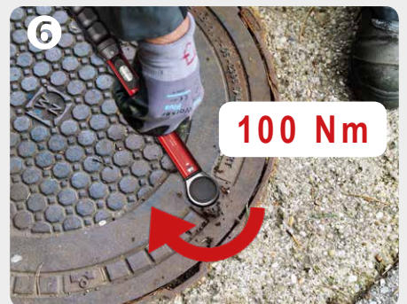
6 Riegel zusätzlich mit Drehmomentschlüssel und Universalnuss SW 22 nachziehen
