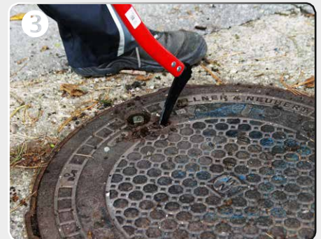
3 Deckel in den Rahmen heben
