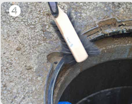
4 Auflageflächen, Verschraubungssitze reinigen, Mörtelreste entfernen
