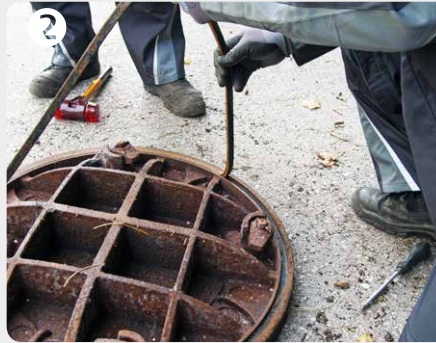
2 Dichtung aus dem Deckel ziehen
