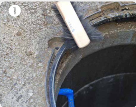
Auflageflächen reinigen
