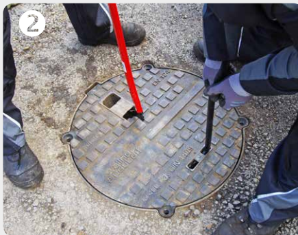
Deckel in den Rahmen heben
