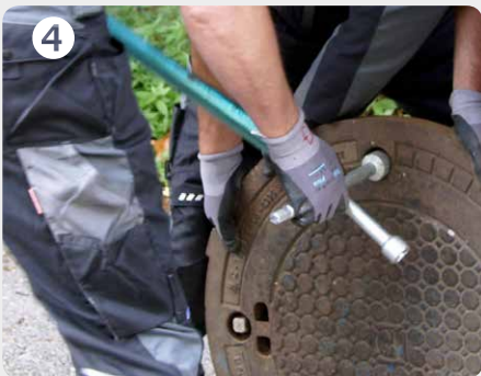
4 Für eine bessere Hebelwirkung kann eine Rohrverlängerung über einen Seitenarm des Schlüssels geschoben werden
