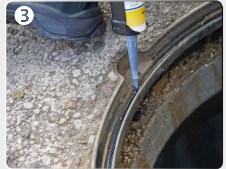
3 MS-Polymer-Kleber aus Kartusche in die Nut einbringen, max. 5 mm breiten Klebewulst ziehen; keine Auslützeit
