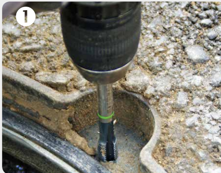
1 Gewinde mit Gewindebohrer vorsichtig, bei niedrigster Drehzahl nachschneiden
