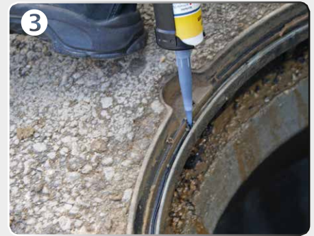
3 MS-Polymer-Kleber aus Kartusche in die Nut einbringen, max. 5 mm breiten Klebewulst ziehen; keine Auslüftzeit
