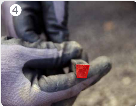
4 Dichtung aus Polymer, Querschnitt trapezförmig, Schmalseite unten
