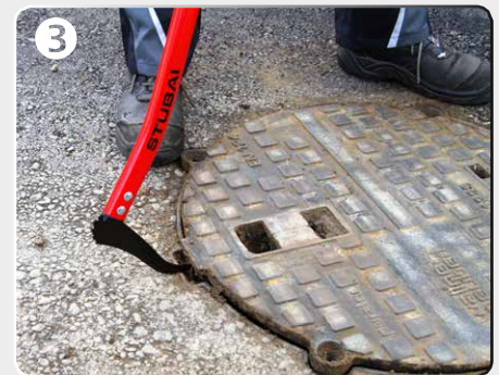
3 Deckel aus Rahmen heben
