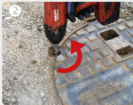
2 Schrauben lösen SW 17
