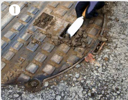
1 Schrauben und Ausbeboffnungen freilegen, reinigen
