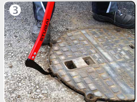
3 Deckel aus Rahmen heben
