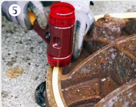
5 Mit vorsichtigen Schlägen mit dem Schonhammer rundum gleichmäßig in die Nut einklopfen
