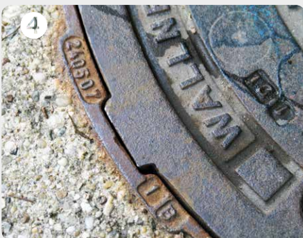
4 Die Gussnase des Deckels in die entsprechende Ausnehmung des Rahmens setzen
