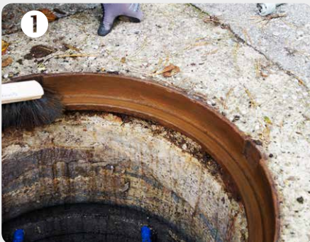
1 Auflageflächen reinigen
