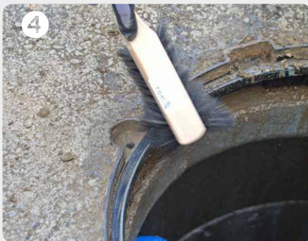
4 Auflageflächen, Verschraubungssitze reinigen, Mörtelreste entfernen
