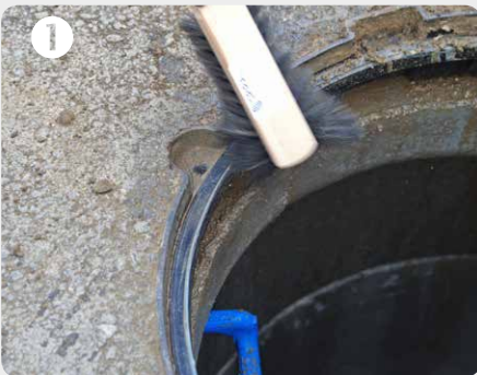
Auflageflächen reinigen
