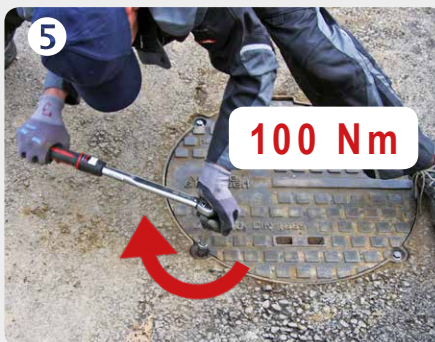
Schrauben mit Drehmomentschlüssel (im Koffer vorhanden) anziehen
