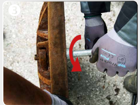
3 Bolzen mit Kreuzschlüssel oder Universalnuss SW 22 gegen den Uhrzeigersinn aus dem Gussriegel drehen
