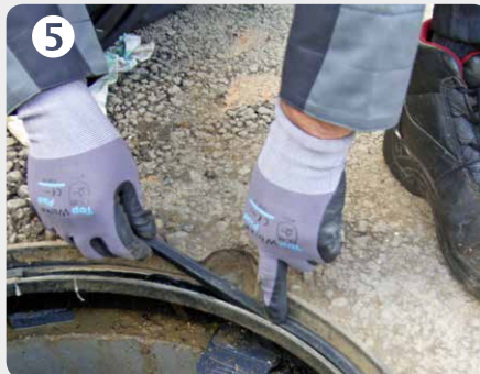
5 Dichtung ablängen, dabei nicht dehnen; gleichmäßig rundum in die Nut drücken
