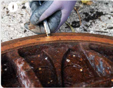
1 Dichtung aus der Deckelnut drücken
