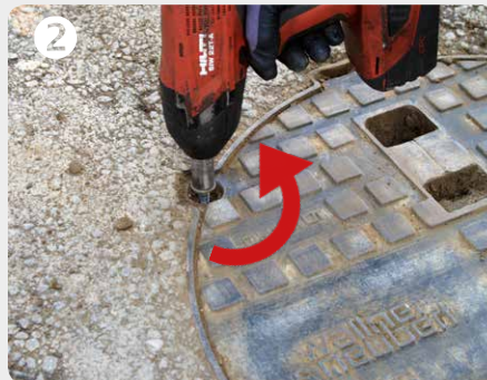
2 Schrauben lösen SW 17
