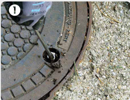
1 Schrauben und Aushebeöffnungen freilegen, reinigen
