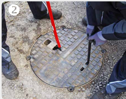
Deckel in den Rahmen heben
