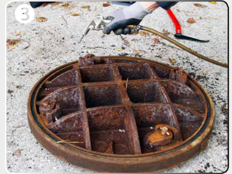
3 Leere Nut reinigen; falls vorhanden mit Druckluft ausblasen Es wird kein Kleber verwendet
