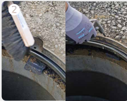
2 Nut reinigen, Kleberreste entfernen; mit Druckluft - falls vorhanden - ausblasen
