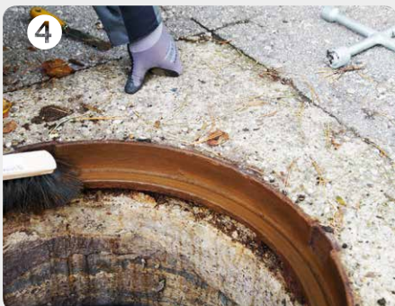
4 Auflageflächen, Verschraubungssitze reinigen, Mörtelreste entfernen
