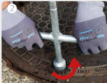
2 4-kant Riegel mit Kreuzschlüssel durch Drehung gegen Uhrzeigersinn bis zum Anschlag lösen
