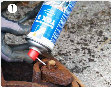
1 Gewinde der Riegel mit Rostlöser einsprühen, ausreichend einwirken lassen
