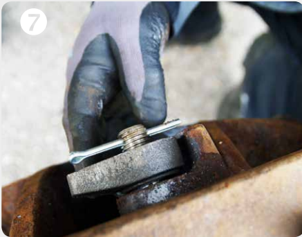
7 Gussriegel auf den Gewindebolzen bis zum Anschlag drehen; Sicherungssplint setzen, Enden des Splints umbiegen
