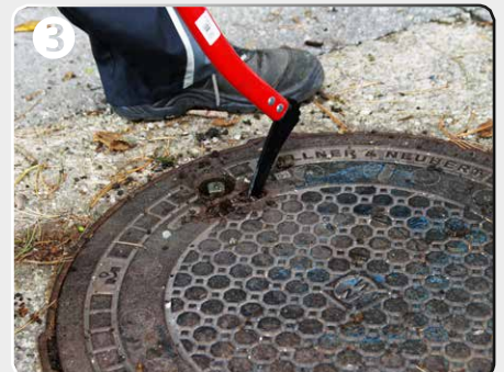
3 Deckel aus Rahmen heben
