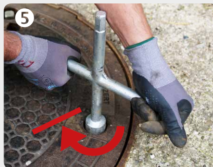
5 Riegel im Uhrzeigersinn bis zum Anschlag drehen; nur dann ist der Deckel wirklich gesichert
