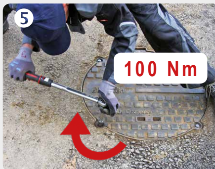
Schrauben mit Drehmomentschlüssel (im Koffer vorhanden) anziehen
