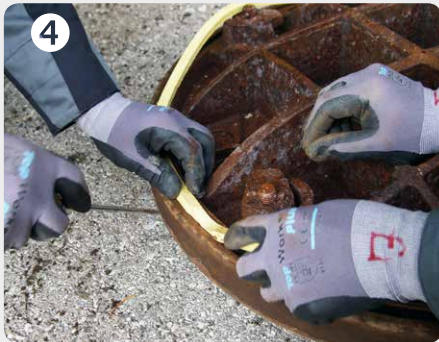
4 Dichtung aus Polymer, Querschnitt trapezförmig, Breitseite unten, in die Nut drücken
