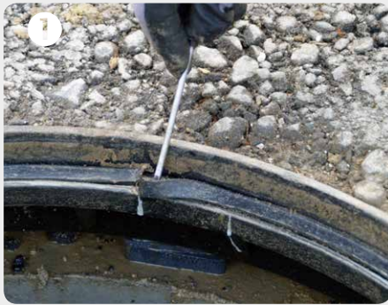
1 Dichtung beim Stoss lösen und aus der Nut in der Auflagefläche ziehen
