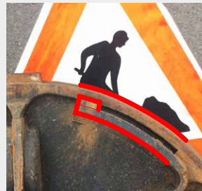
richtige horizontale Pos.: Federstab bogen etwa parallel zur Deckelrundung, Vorderkante des Federstabes ca. 8 mm über Rahmeninnenkante
