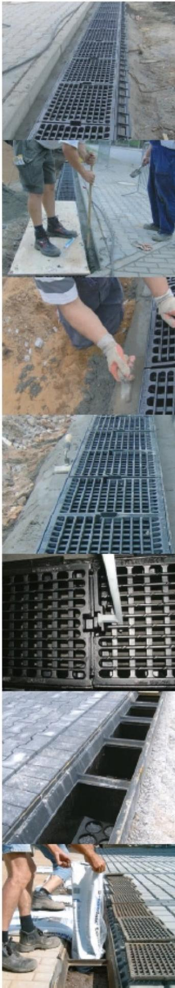
Anschließend Beton C12/15 und C20/25 (alte Bezeichnung B15/25) lagenweise (ca. 15-20 cm-Lagen) einbringen und verdichten.
