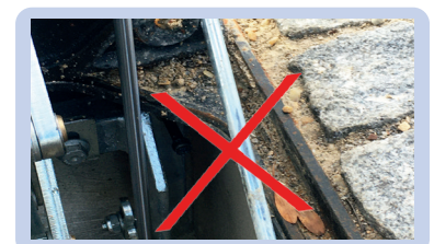
Abb. E: SO NICHT: Sand auf Dichtung und Auflagefläche
