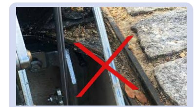
Abb. 10: SO NICHT: Sand auf Dichtung + Auflagefläche
