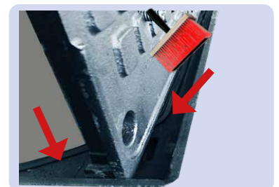
Abb. 9: alle Spalten zw. Rahmen + Deckel, Dichtung reinigen
