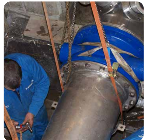
Montage einer großdimensionierten Pumpendruckleitung vor Ort
