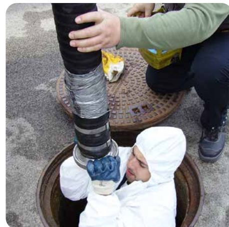
Schwierige Wartungsverhältnisse schrecken uns nicht ab!
